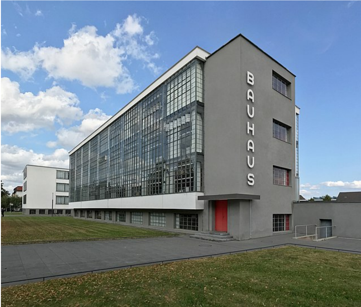
Figure 1. The Bauhaus building in Dessau , Gunnar Klack, Bauhaus Dessau, Gropiusallee Ecke Bauhausstraße, Dessau-Roßlau, Werkstättenflügel Foto aus Richtung Südosten , 2020, Wikimedia Commons, https://commons.wikimedia.org/wiki/File:2020-09-18-Bauhaus-Dessau-Werkstattfluegel-Ecke-2.jpg CC BY-SA 4.0.
